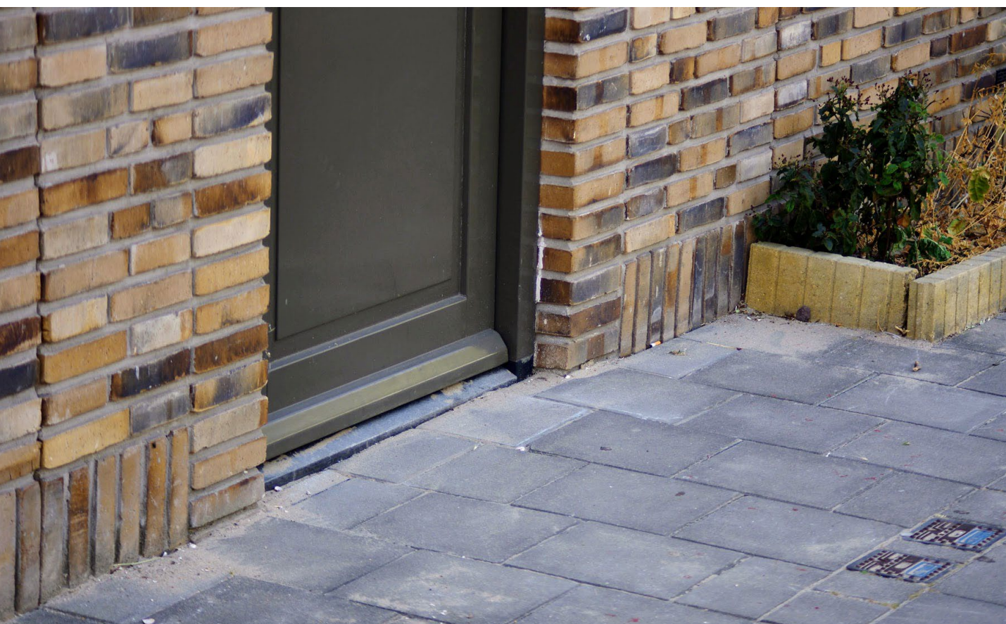
Foto 10. Ook bij nieuwbouw lijken drempelhoogtes soms verrassend laag vanuit het oogpunt van wateroverlast-risico's. Mogelijk is rolstoeltoegankelijkheid hier doorslaggevend geweest.
