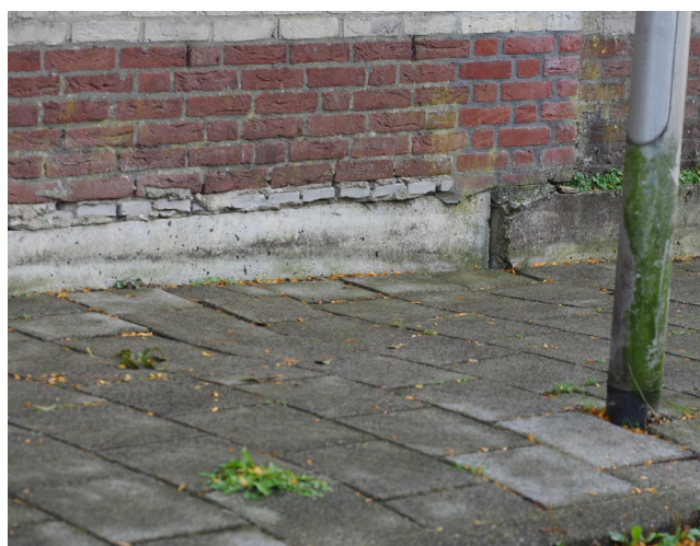
Foto 3. Ook als een woning niet op houten palen of op staal is gefundeerd kan er zettingsproblematiek zijn rond de woning. Een deep-dive kan dat aan het licht brengen.
