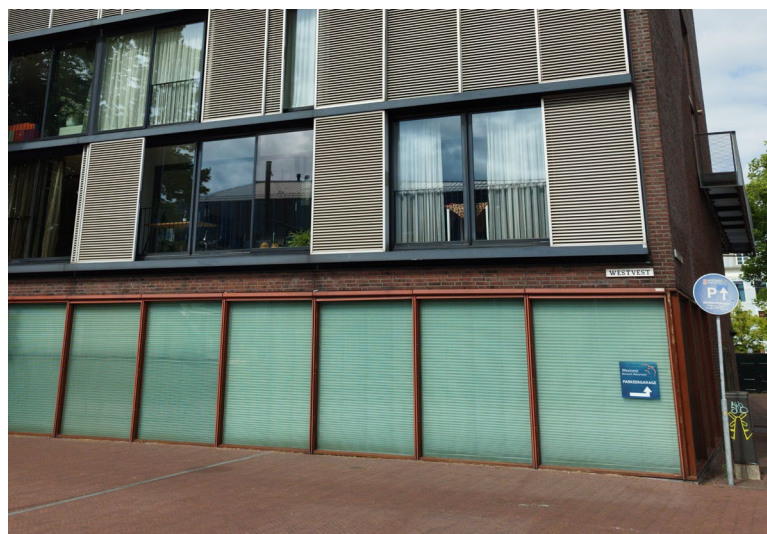
Foto 9. Buitenzonwering is een zeer effectieve maatregel in het tegengaan van hittestress. De bewoner moet wel worden geïnformeerd over hoe deze het best kan worden gebruikt.
