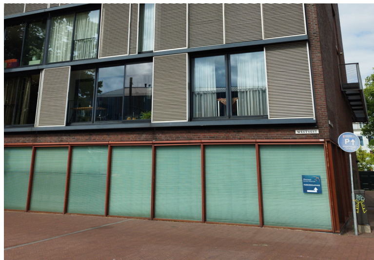
Foto 9. Buitenzonwering is een zeer effectieve maatregel in het tegengaan van hittestress. De bewoner moet wel worden geïnformeerd over hoe deze het best kan worden gebruikt.
