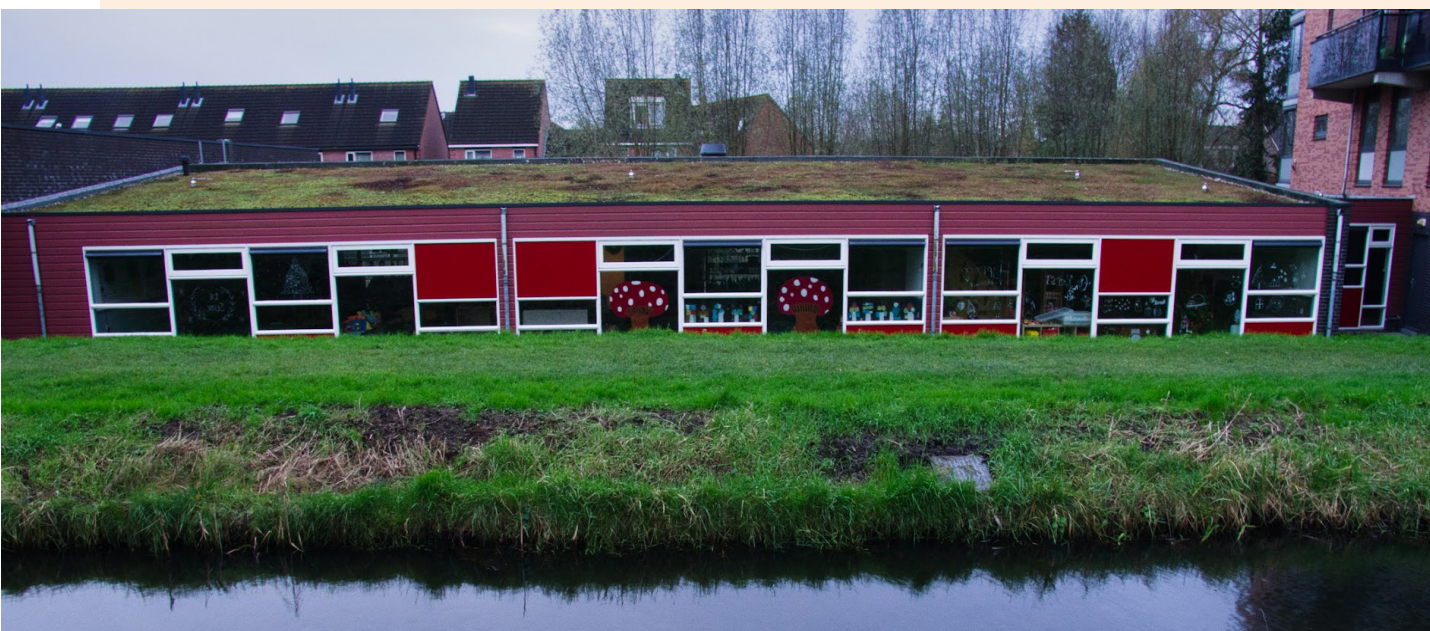
Foto 1. Elk klimaatthema krijgt in FCAB een afzonderlijke score. Een minder goede score op overstromingsrisico (vanwege lage ligging in een polder) laat zich niet uitmiddelen met een betere score op hittestress (bijvoorbeeld dankzij een groen dak). Het schoolgebouw op de foto illustreert dat overstromingsrisico en hittestress afzonderlijke opgaven zijn.
