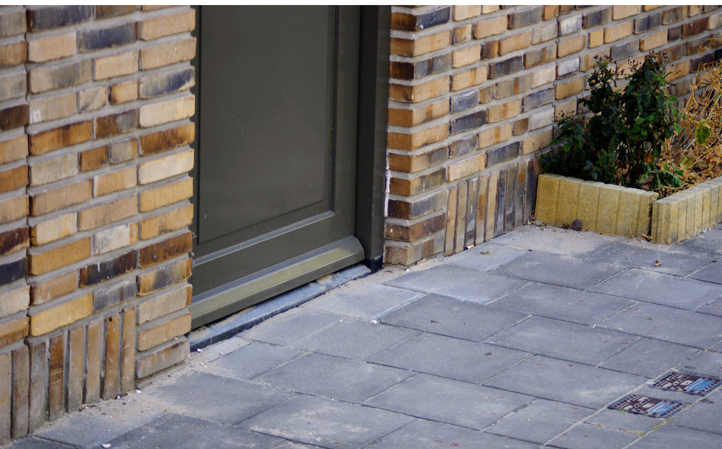
Foto 10. Ook bij nieuwbouw lijken drempelhoogtes soms verrassend laag vanuit het oogpunt van wateroverlast-risico's. Mogelijk is rolstoeltoegankelijkheid hier doorslaggevend geweest.
